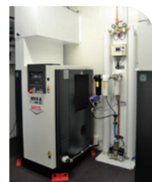
AIR MIL'S 2 Centrale d'air technique avec compresseurs à pistons lubrifiés
